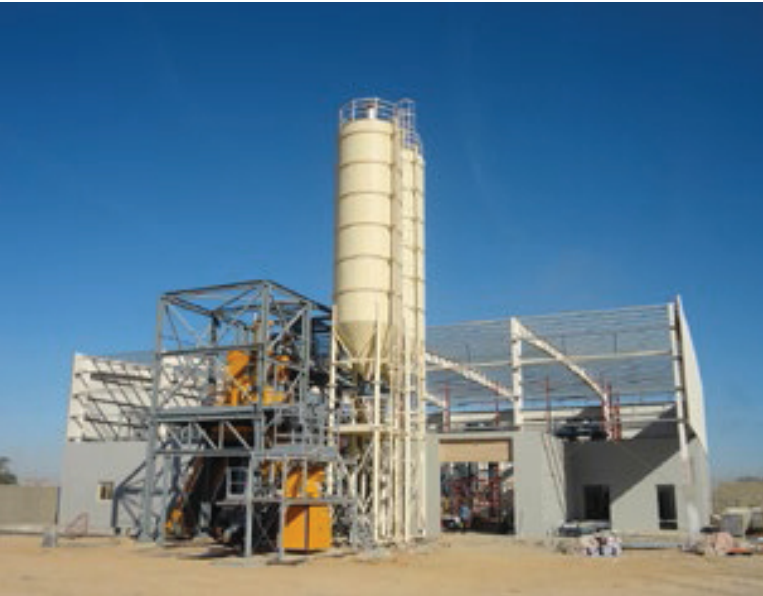
Дозирующая и смесительная установка включает два смесителя производства Skako: Apollo 1500 для бетона ядра и модель 500 для облицовочного бетона
